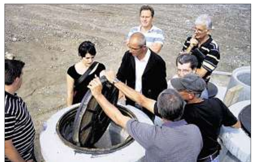
Zogen gestern den Schieber: Willy Jorns von der ausführenden Firma Geoterra (weisses Hemd Mitte) informiert. (Roger Geier)
