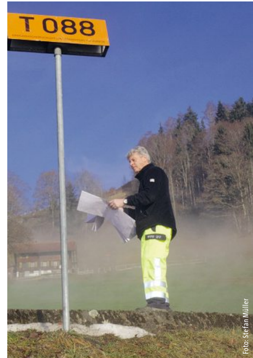
Die orangefarbenen Tafeln verraten: Hier verläuft die Erdgaspipeline.
