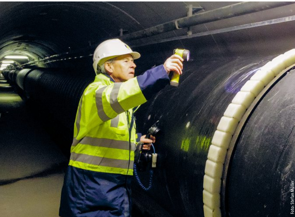
Streckenchef Alois Grüter bei der Inspektion der Rohrleitung im Lammschluchtstollen bei Schöpfheim.
